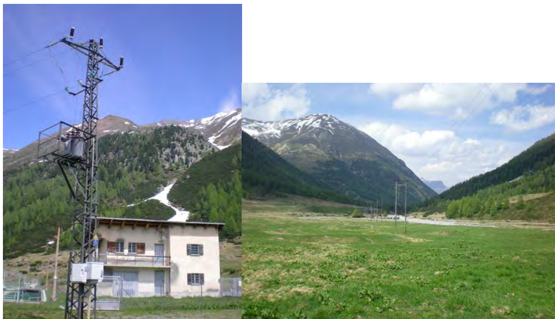
Figura 3.5 – Loc. Alpe Vago-Valle di Livigno: le linee elettriche presenti costituiscono un forte rischio di collisione ed elettrocuzione a danno dell'avifauna poiché una buona parte dei tralicci presenti non è stata debitamente isolata o segnalata (Foto E. Bassi).
